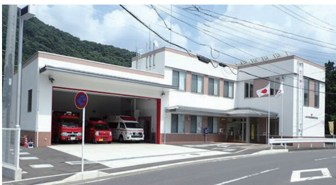
厚木市北消防署清川分署
